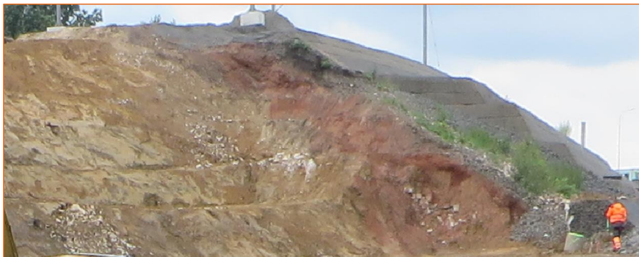
Obrázek 8 Řez náspem Dalovice 2 - jílové jádro (světlé) a pevnější obsyp (červený)
